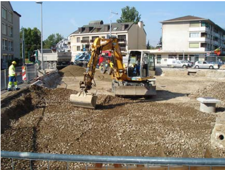
Mise en place du terre pierre
