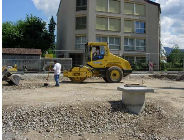
Mise en place de la grave
